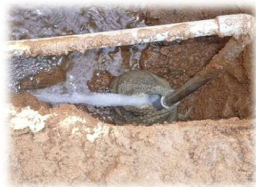
写真5-8 漏水管
