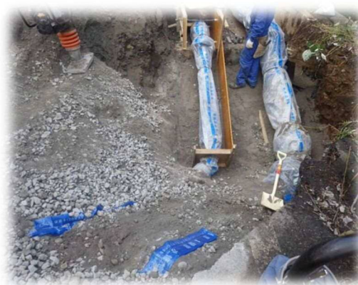
写真 5-4 老朽管の更新
