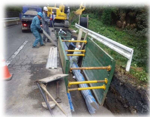
写真 5-4 老朽管の更新
