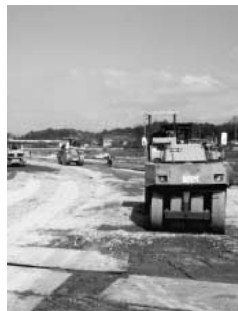
完成に向けて町道1-22号線
