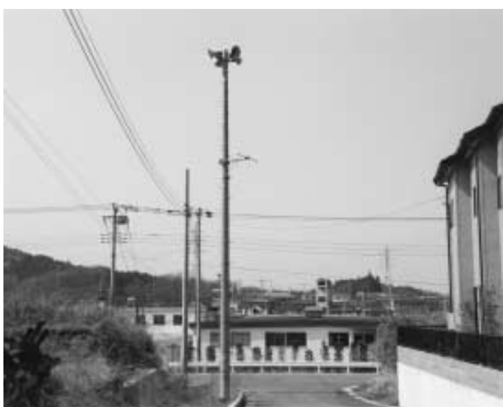
防災無線施設（平沢地区）
