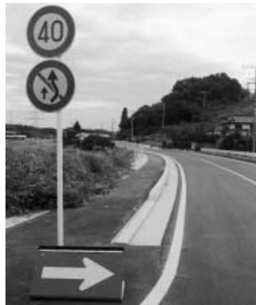
町道2-9号線歩道
