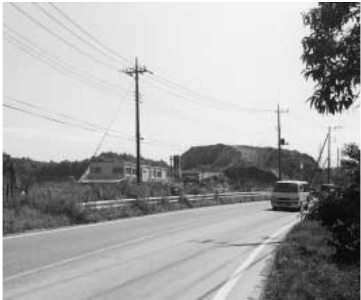
工事が開始されたカインズホーム予定地
