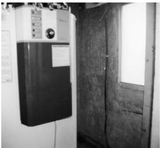
アスベストが除去された壁
