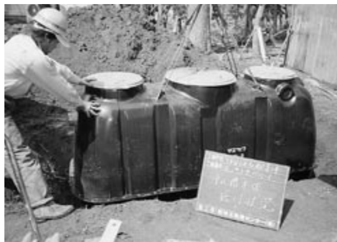
合併浄化槽の埋設工事
