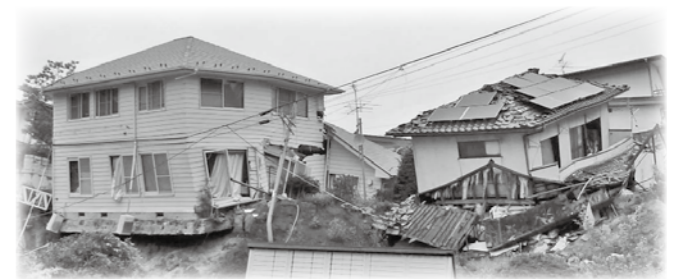
東日本大震災で多発した地すべり被害
