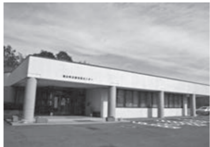
改修予定の北部交流センター
