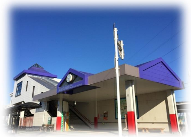
<武蔵嵐山駅橋上駅舎>
