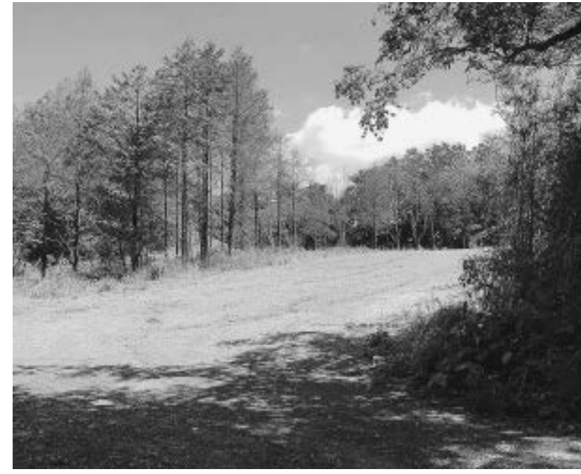
鎌形地区内のサバイバル場駐車場の埋立て状況＝H30.5.14
