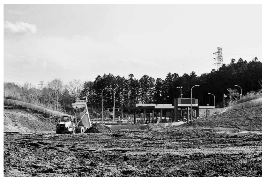
インターチェンジランプ内の工事の様子（3月12日撮影）
