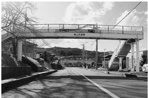
修繕工事予定の嵐山歩道橋
