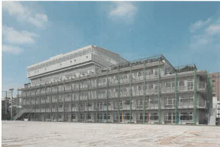
グラウンド側から見た校舎外観
