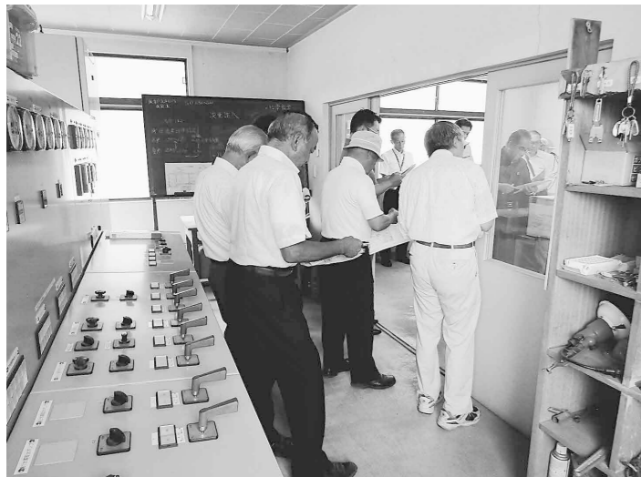
第一浄水場の現地調査=R元.9.6
