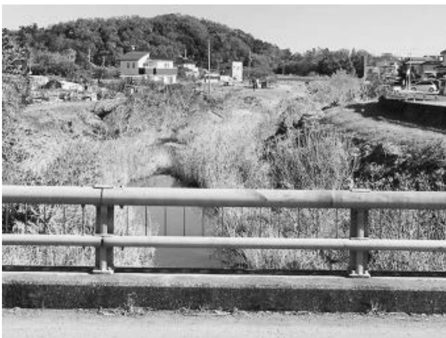
市野川（川袋橋下流）＝R元. 12. 8
