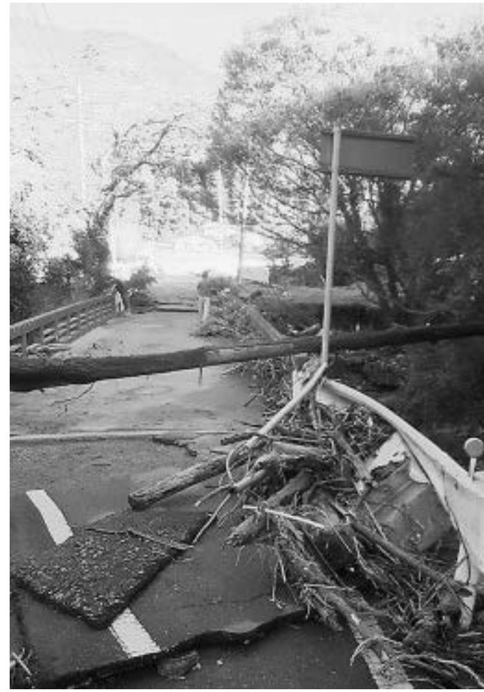
10月12日の台風19号で被災した、遠山地区・ときがわ町境の「谷川橋」 「280mm」という雨量は今後も発生する思いを共有すべし=R元. 10. 13
