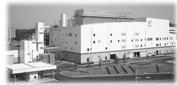
オリックス資源循環（株）寄居工場
