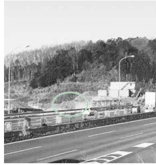
インターランプ内から出てきた産廃と思われる山
