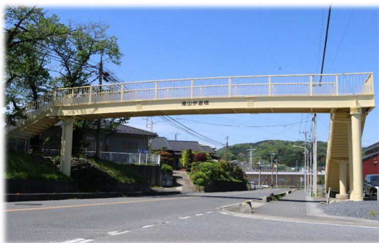
▲改修した嵐山歩道橋
