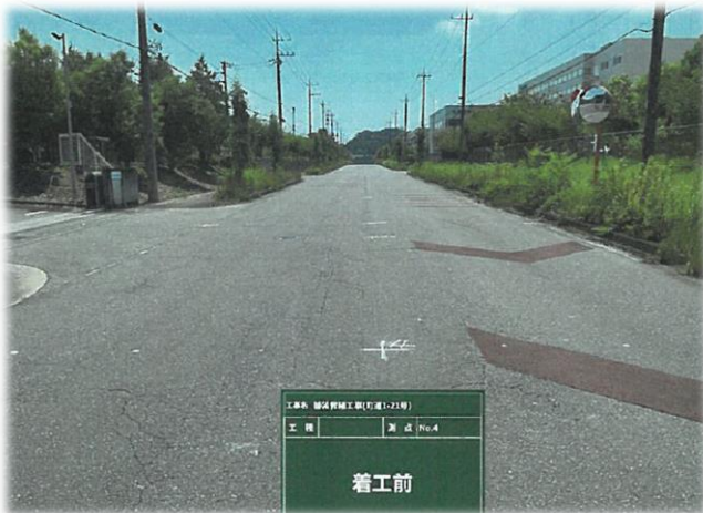
道路整備(着工前)
