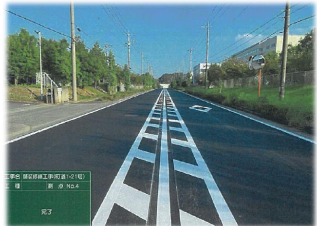
道路整備(完了)
