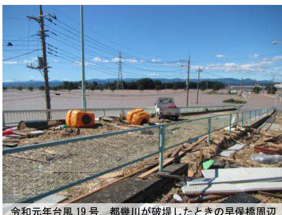
令和元年台風19号 都幾川が破堤したときの早侯橋周辺
