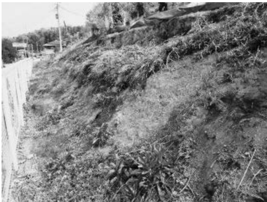
七郷小学校敷地内の崩落現場＝R2.4.18（教育委員会提供）
