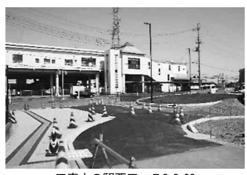
工事中の駅西口=R3.3.23
