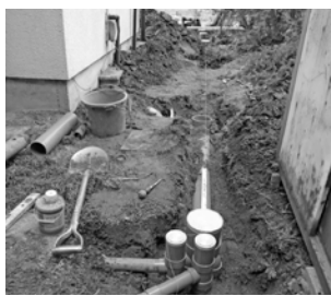
③ 配管工事
