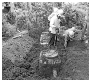
① 単独浄化槽撤去
