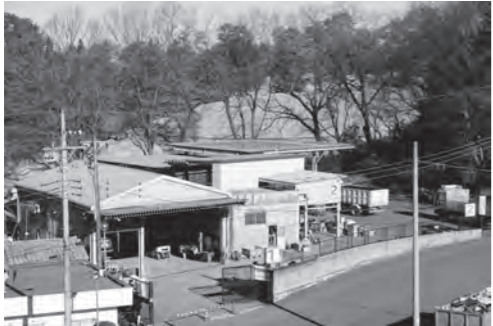
小川地区衛生組合 不燃物処理施設
