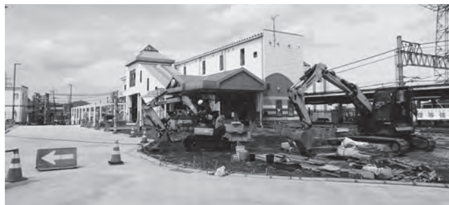
駅西口工事の様子＝R6.4.4
