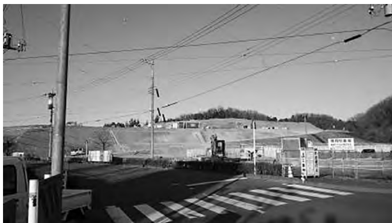
花見台拡張工事=R6.3.23
