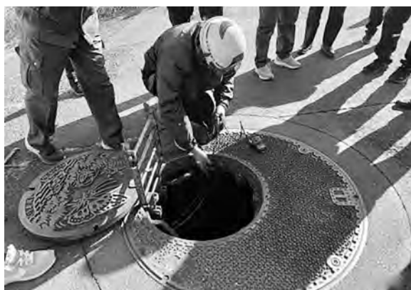
町内マンホール内視察=R7.2.21
