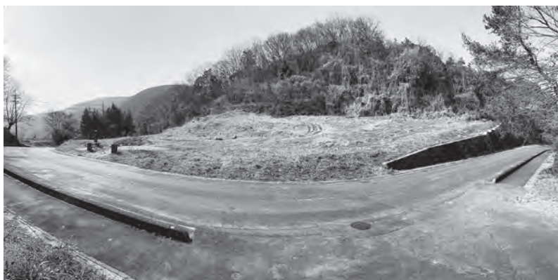
新浄配水場建設予定地（通称 遠山道 太平山登山口付近）
