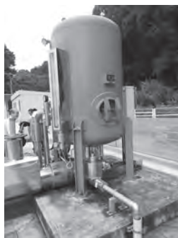
第3水源にある エアータンパー (水撃防止装置)
