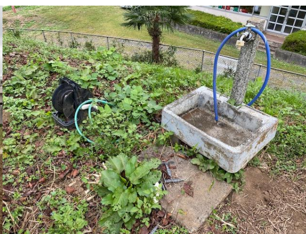
d 水道施設
