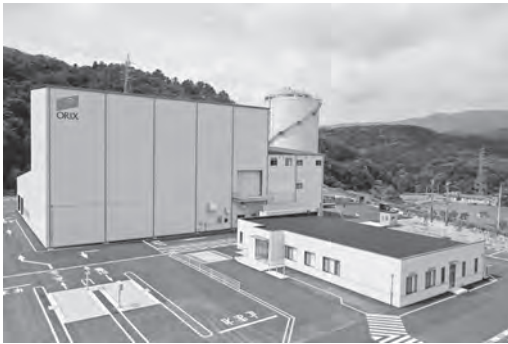
オリックス資源循環(株) 寄居バイオガスプラント
