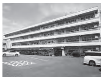
菅谷中学校の1階を学童保育室に改修
